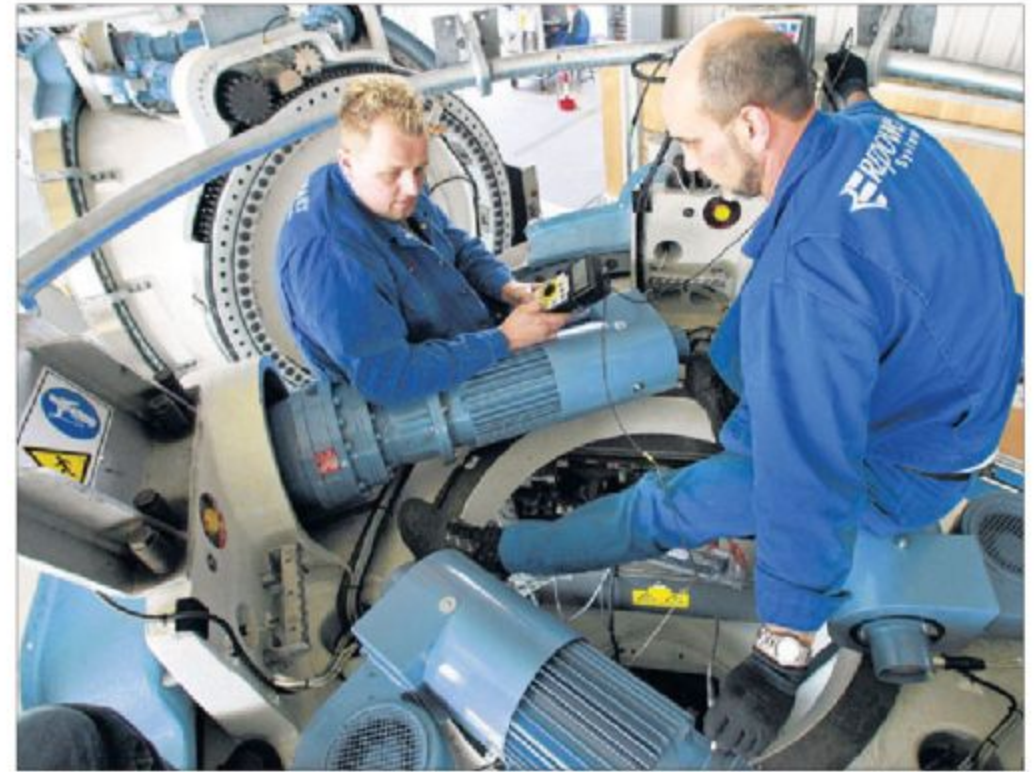
Kontrollarbeiten an einer Windkraftanlage: Fachkräfte für alle Bereiche werden von vielen heimischen Unternehmen dringend gesucht. MT-Archivfoto: dpa
