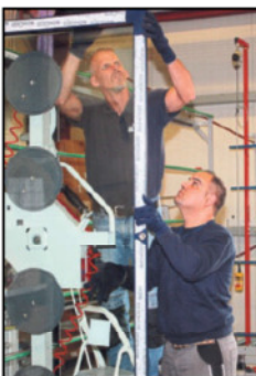
Kali Kamiran (rechts) baut gemeinsam mit Vorarbeiter Stephan Kelle die Scheibe in den Fensterrahmen.
